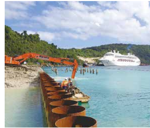
ポートビラ港ラペタシ国際多目的埠頭整備事業
